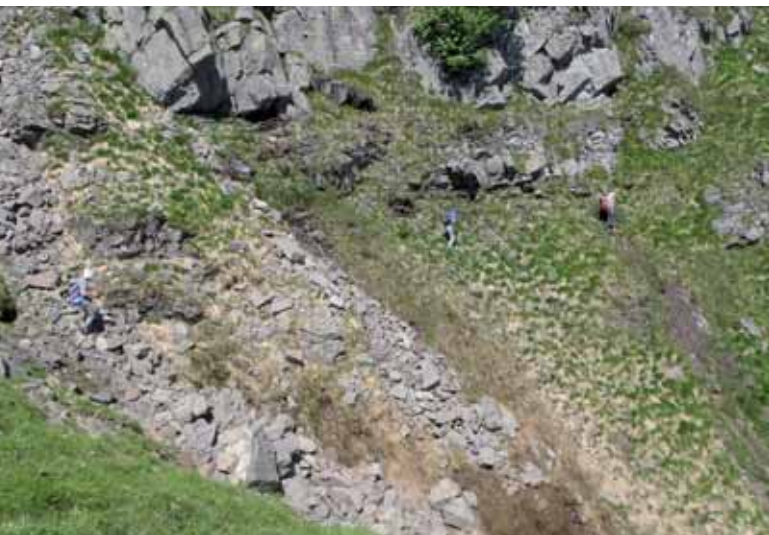
Canalone franoso della prima parte del sentiero
